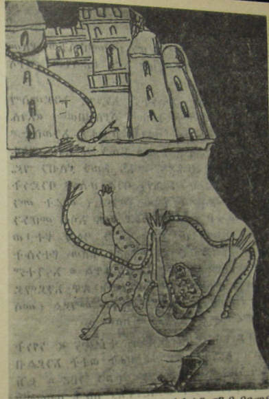
መሠረቱ ጥልቅ የሆነውን የአፄ ፋሲለን ግንብ በገመድ ጠልፎ ለመጣል መሞከር ይህን የመሰለ አደጋ ያተርፋል።
