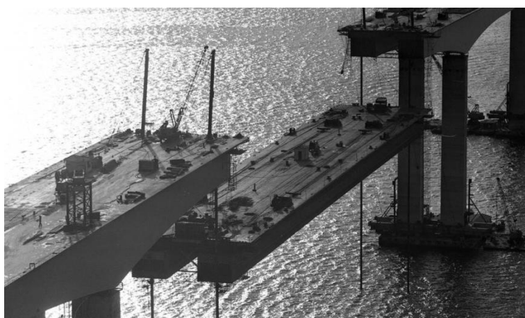
Figura 5 – Construção da Ponte Rio-Niterói
