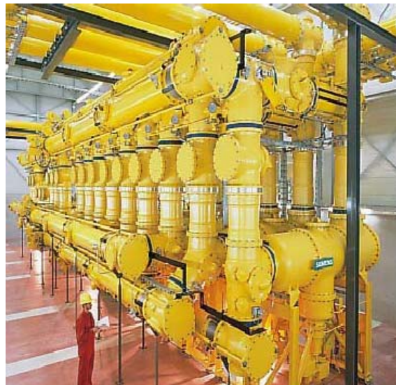
Figura 4.10 Subestação Compacta.
