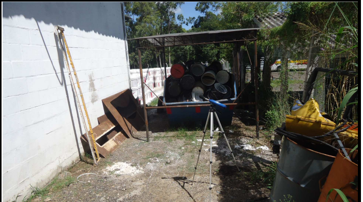
7.10 Foto BR 290 Km 30 Casa de Placas OESTE Sentido Litoral / Capital
