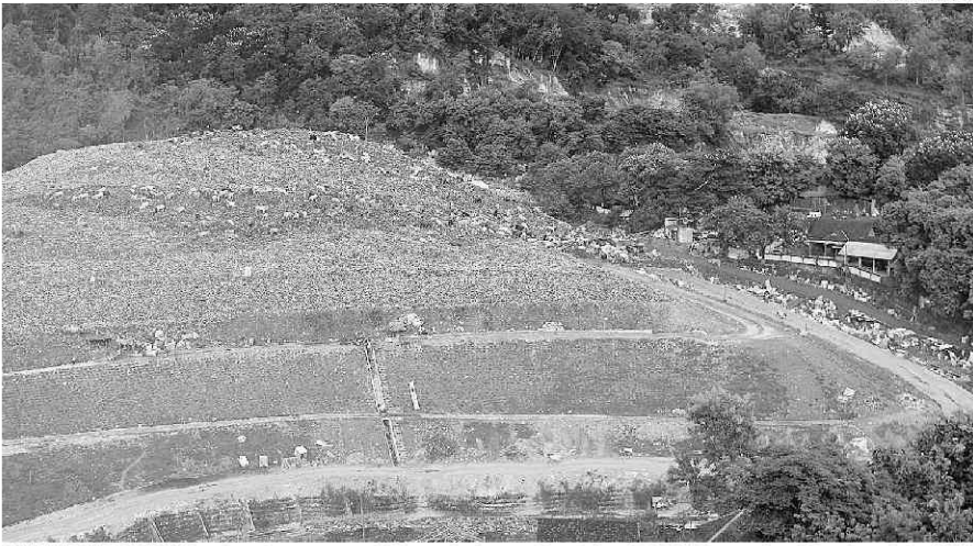
PEMBUANGAN SAMPAH Proyek pembangunan tanggul di Tempat Pembuangan Sampah Terpadu (TPST) Pyungan, Bantul, Yogyakarta, Selasa (15/2). Pemerintah Daerah Istimewa Yogyakarta berencana memperluas TPST Pyungan. Diperkirakan pada 2023, TPST tidak mampu lagi menampung sampah.
