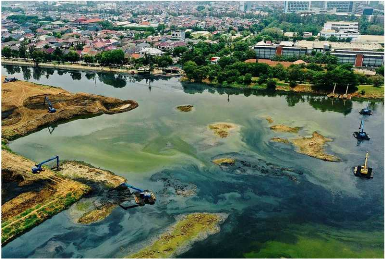
Foto udara ekskavator yang dikerahkan Dinas Sumber Daya Air DKI Jakarta untuk mengeruk Waduk Ria Rio di Pulau Gadung, Jakarta Timur, Senin (12/10/2020). Kedalaman Waduk Ria Rio semestinya 5-6 meter. Namun, karena sedimen, di beberapa bagian kedalamannya tinggal 1 meter. Pengerukan waduk dan saluran air terus dilakukan Pemerintah Provinsi DKI Jakarta untuk mengantisipasi datangnya musim hujan.
