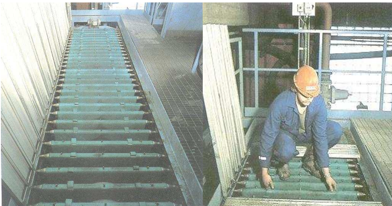
Inspección y retiro de la tela en el Filtro Prensa
