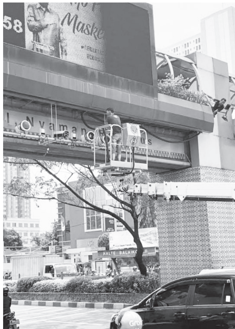
Pemasangan alat perekam elektronik tilang di jembatan batas Kota Depok di Jl Margonda. (angga)
